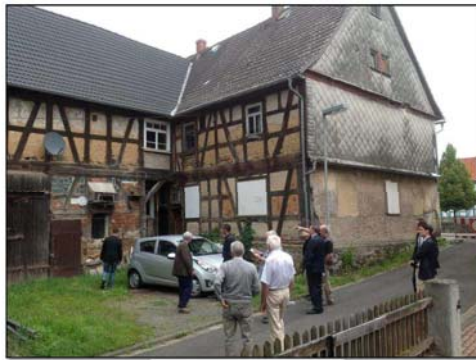
Ortsbegehung in Freilenseen
